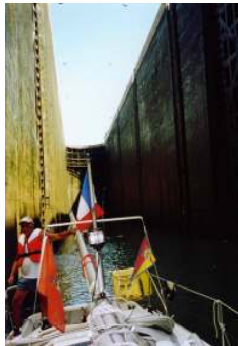
In der gigantischen Schleuse von Bollène.
